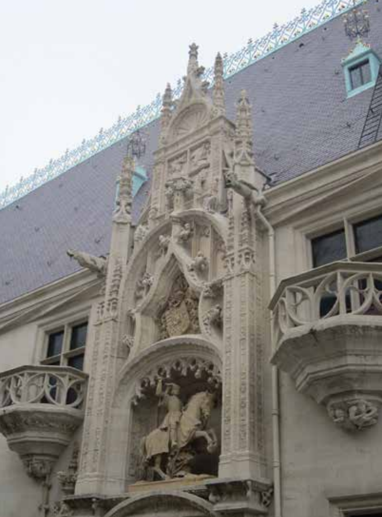
Détail de la façade principale du palais des ducs de Lorraine. Photo de l'auteur.
