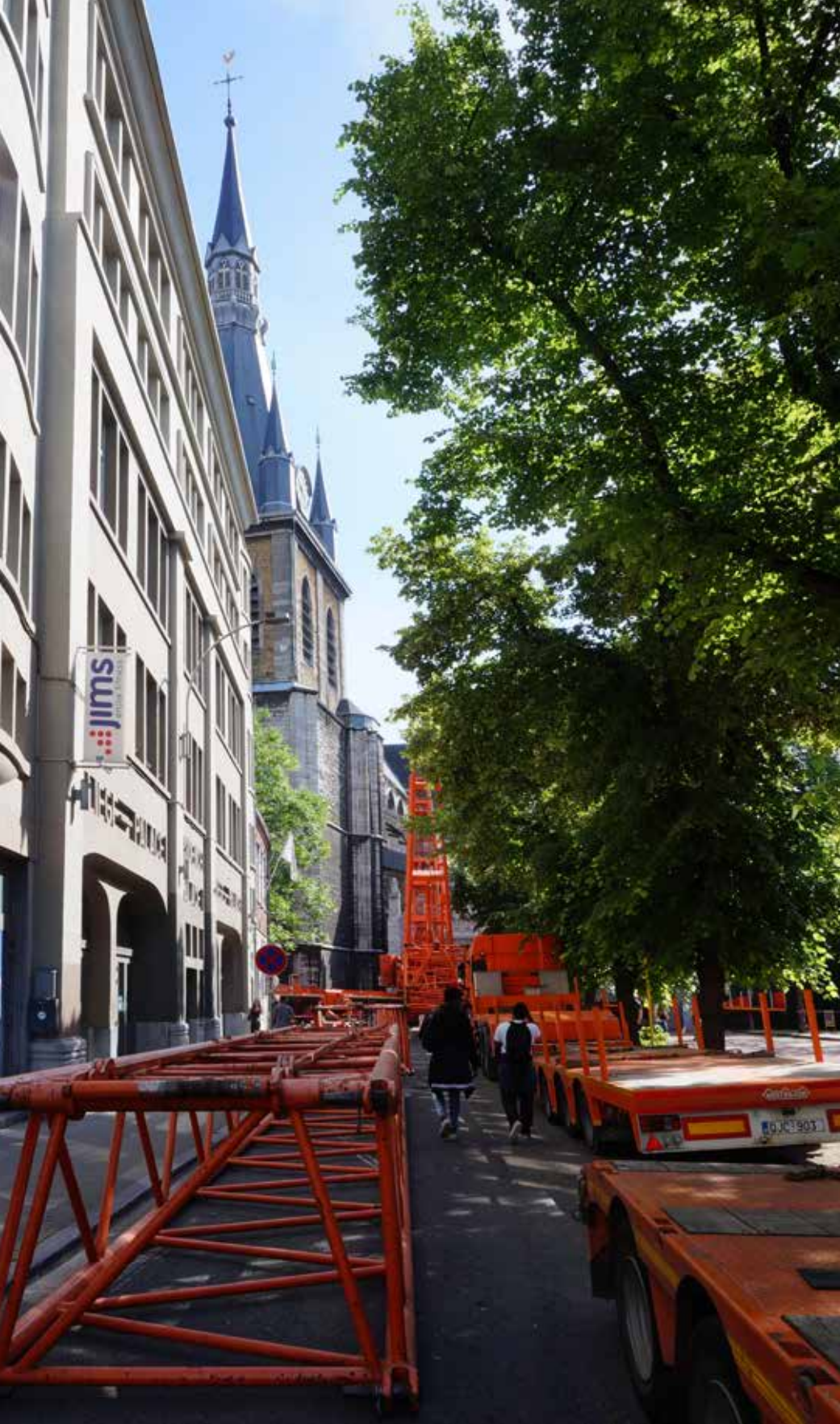
Montage de la grue sur la place Saint-Paul en juin 2016.
