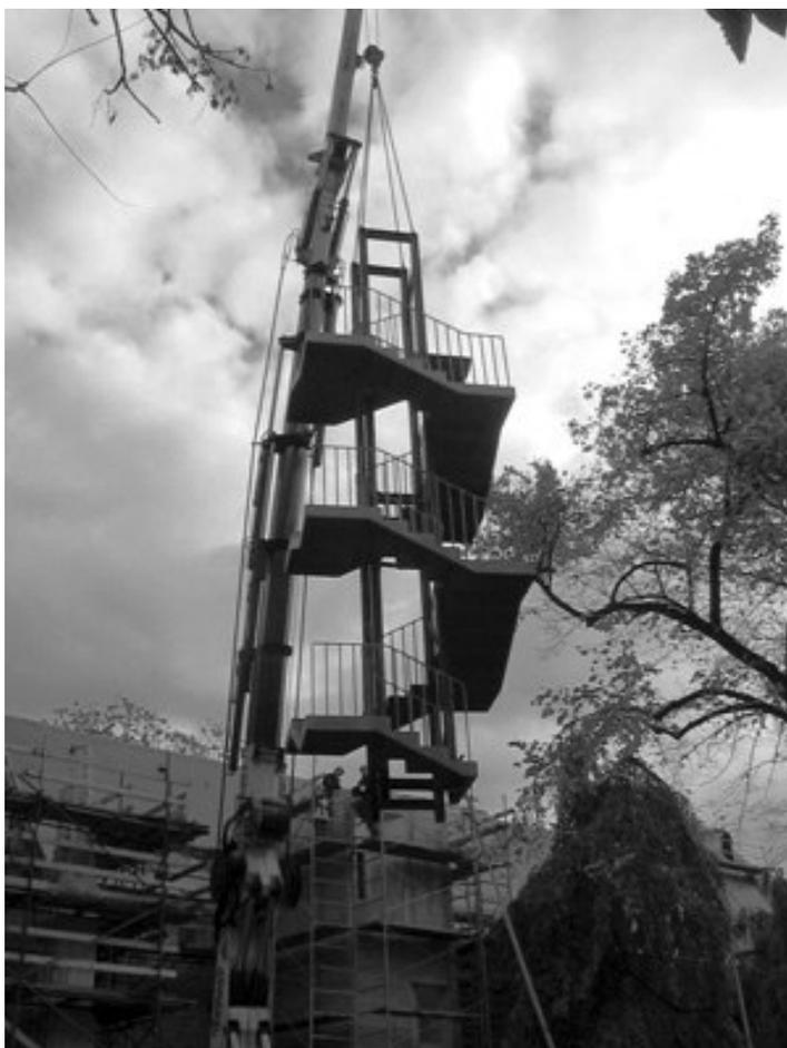
*Ci-contre et en couverture, l'installation de l'escalier de la tourelle de la place Saint-Paul. Cette tourelle d'évacuation en cas d'incendie, contribue, avec la dalle en béton coulée au 2ème étage de l'aile ouest du cloître (côté place Saint-Paul) , à la stabilisation du bâtiment. Il s'agit de contribuer un hors plomb de plus de 30 cm, visible à l'œil nu.*
